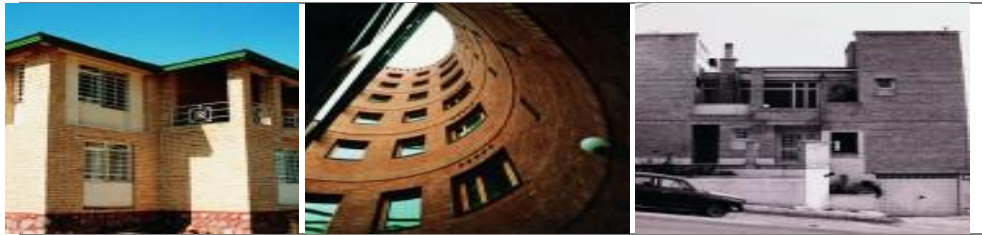
خانه‌ی مرشدزاده، در رودهن، کار امیرحسین طاهری مجتمع نگاران، در تهران، کار محمدرضا نیکبخت ویلاي فشنک، در طالقان، کار حسین ناصری
